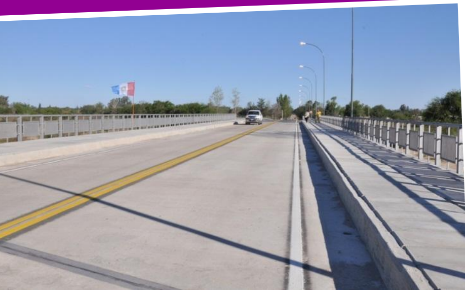
PUENTE RÍO SEGUNDO - PILAR
