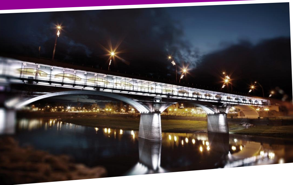
PUENTE VILLA CARLOS PAZ
