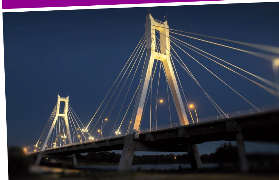
PUENTE RÍO CUARTO
