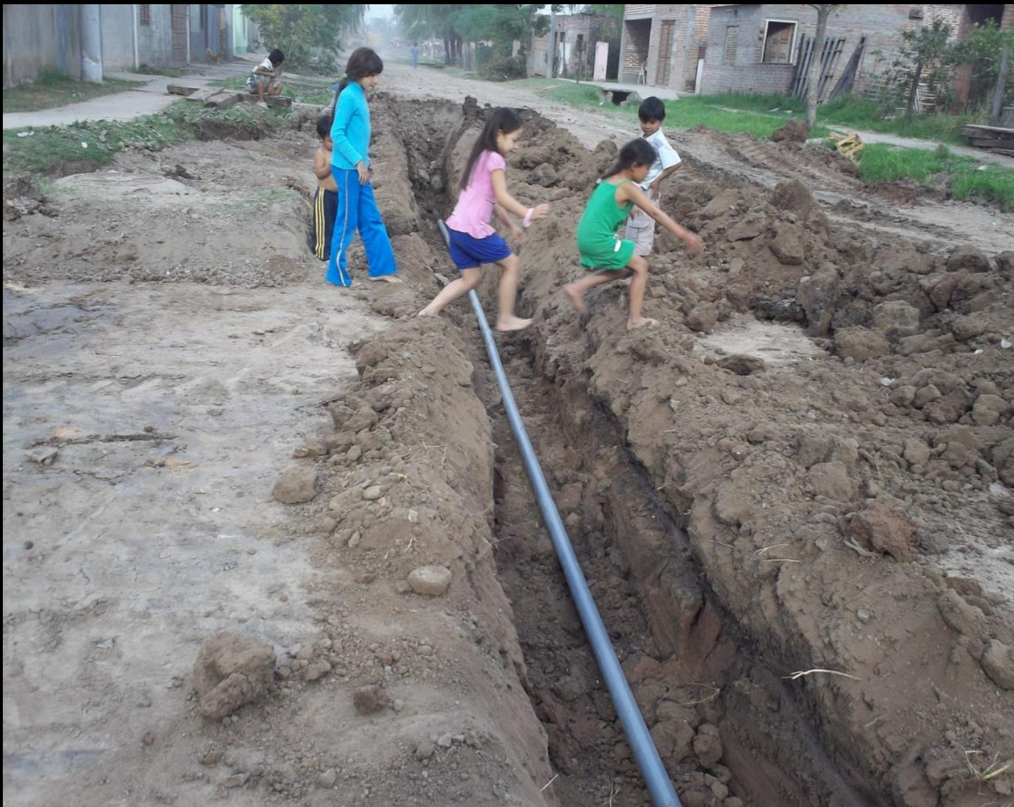
Niños atravesando una obra de infraestructura urbana (pavimento y agua) en una localidad del interior del Chaco (foto DVP Chaco)
